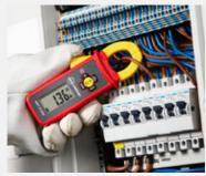
Fehlersuche in elektrischen Anlagen und Messung von Strömen im Gleich- und Wechselstrombereich an freiliegenden Leitungen in einem Unterverteiler.
