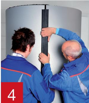
Dopo aver fissato il profilo di compensazione, è possibile procedere con la chiusura dell'isolamento ECO SKIN mediante due apposite chiusure a gancio.
