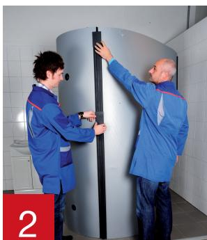
Poté perforovaný díl izolace s rounem napněte přes místa pro přichycení na vnitřní straně.
