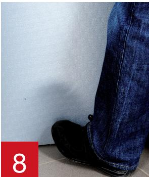
De ECO SKIN-isolatie mag niet worden geknikt of ingedrukt, anders bestaat er kans op beschadiging (witbreuk). De door onvakkundige omgang ontstane witbreuk kan met behulp van een warme föhn voorzichtig worden verwijderd of geminimaliseerd.
