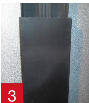
Um ein Öffnen der Hakenverschlussleiste während des weiteren Montagevorganges zu verhindern, sollten die mitgelieferten Abdeckmontageleisten über die Hakenverschlussleiste eingerastet werden.
