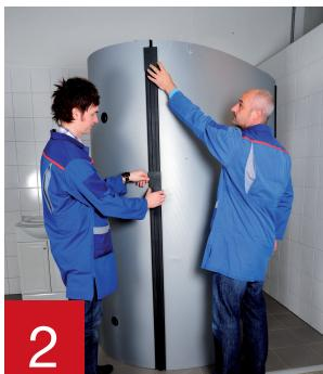
Zet daarna het isolatiecomponent met gaatjes met het vlies naar binnen over de aansluitingen.
