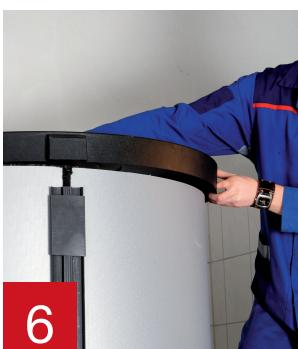
ECO SKIN - Posizionare correttamente e fissare il coperchio con le rientranze per i profili a gancio sull'isolamento ECO SKIN.
