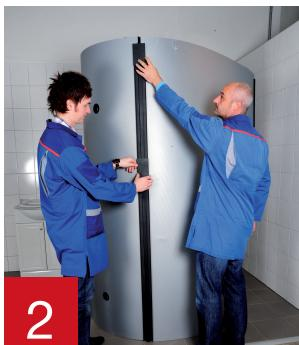
Remonter ensuite l'élément d'isolation perforé, la partie non-tissée tournée vers l'intérieur, par-dessus les raccords. Encrander la pièce d'isolation non perforée sur la barre de fermeture à crochet de la pièce d'isolation déjà installée.
