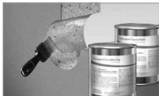
Angeschnittener Bewehrungsstahl ist vor Korrosion zu schützen. Die Aquagard-Beschichtung verschließt die Kernbohrungswandung und verhindert somit das Wasser den Dichteinsatz umwandern kann.
