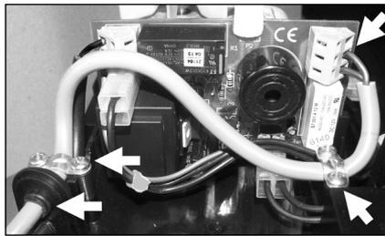
Le câble de raccordement de l'alarme est dirigé dans le boîtier de la pompe à condensats de façon parallèle au câble d'alimentation. Pour ce faire, il est nécessaire d'ouvrir la seconde ouverture dans le passe-câbles.
