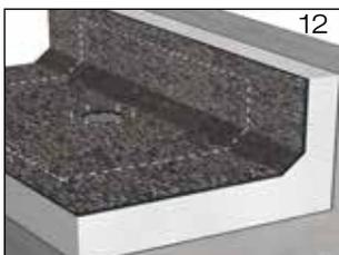
2.7 Zweite Lage der **Dachdichtungsbahn** über Ablauf ausrollen. Mit Locheisen Löcher  $\varnothing = 14$  mm für die Durchführung der Gewindebolzen in der Dachdichtungsbahn vorsehen. Der Losflansch kann als Schablone benutzt werden (Bild 12). Zweite Lage der Dachdichtungsbahn zurückrollen, Anschlussbahn und zweite Lage der Dachdichtungsbahn gemäß Verlegevorschriften des Dachdichtungsbahnerstellers verschweißen.
