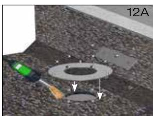
2.8 **Achtung:** Bei Einbau von Losflanschen mit Stauwehr ist es erforderlich, die Bestreuung der zweiten Abdichtungslage durch Erwärmen im Bereich des Losflansches einsintern (einsinken) zu lassen. Auf diese Weise wird ein verfrühtes Anspringen der Notentwässerung durch Kapillarwasser verhindert (Bild 12A). Erst nach Abkühlen des erwärmten Bereichs mit dem Verkleben des Losflansches beginnen.
