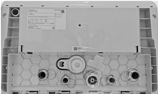
Abb. 10: Montierter Gaskugelhahn um 45° nach rechts gedreht
