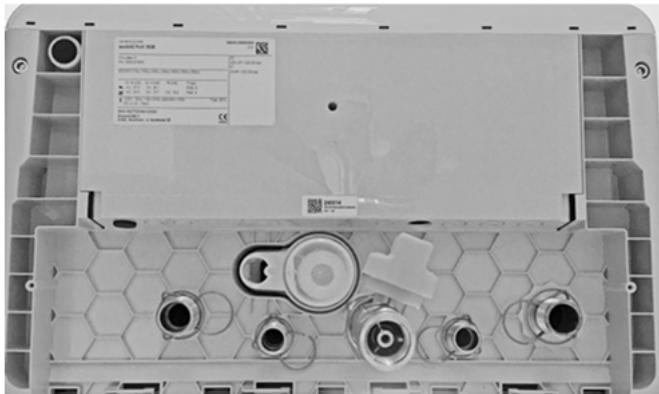
Abb. 10: Montierter Gaskugelhahn um 45° nach rechts gedreht
