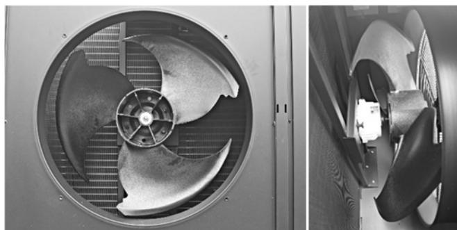
Abb. 54: Ventilator von außen und innen
