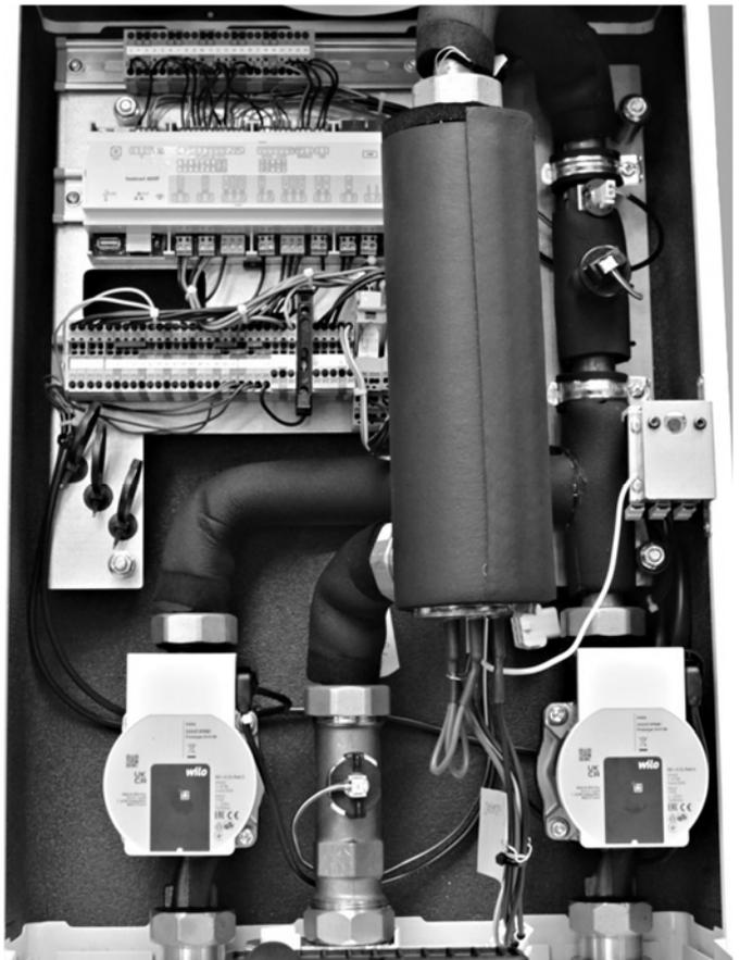
Abb. 63: Anschlussklemmen Regelungseinheit
