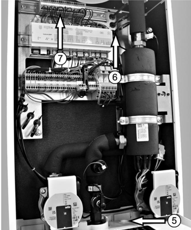
Abb. 37: Kabelführung zur X20 Klemmleiste Kleinspannung
