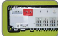
**9** Montieren Sie die Verdrahtungsleitung zur Pumpe in die Anschluss terminals Pump unten rechts an der KL08RF für ein potenzialfreies Schalten der Pumpe. (POTENZIALFREI) **VOLT FREE**
