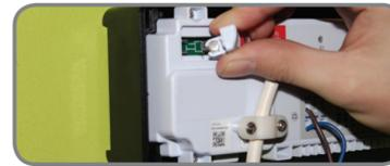
**2** Entfernen Sie die weiße Anschlussplatte.
